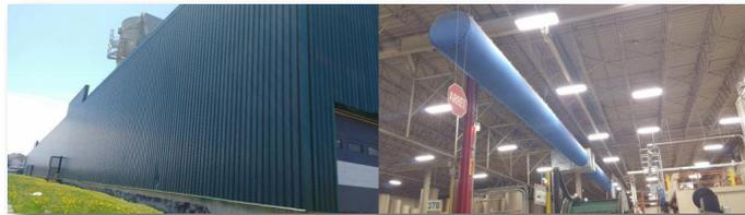
Photo Mur solaire et photo déstratification de Cascades à l'usine de Vaudreuil.
