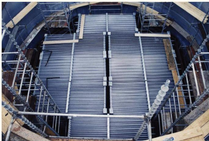
Figure 1 : Réservoir hors-terre avec banque de glace d'une capacité de 27 000 tonnes par heure pour le bâtiment du Comfort Link Market Center. Repris depuis une étude de cas de la compagnie Baltimore Air Coil (BAC).
