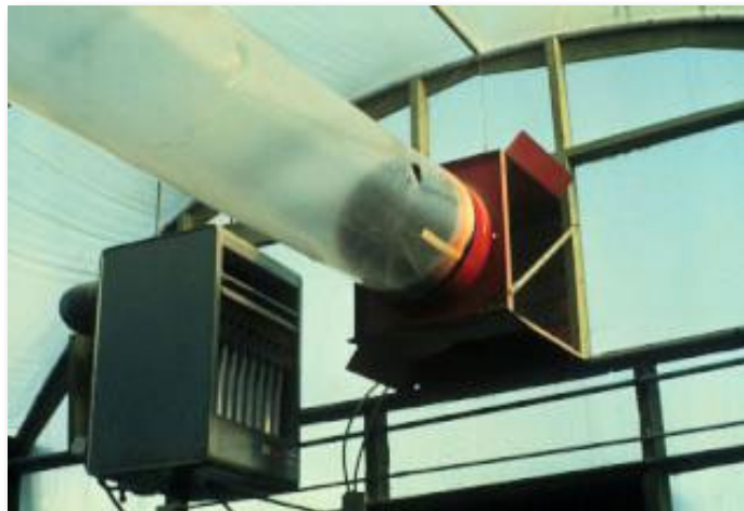
Figure 1 : Système fan-jet type.
